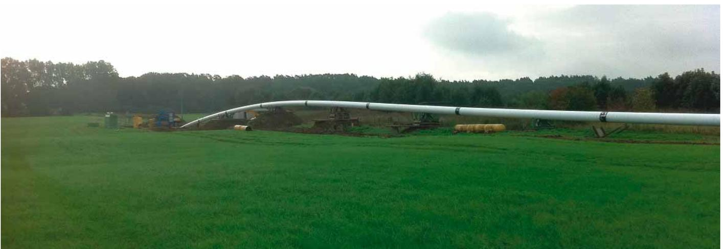
Rohrstrang DN 600 mit PP-Ummantelung beim Einzug.
