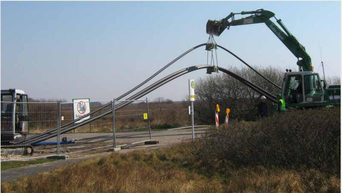
Einzug HDPE-Rohrbündel Bohrung 3
